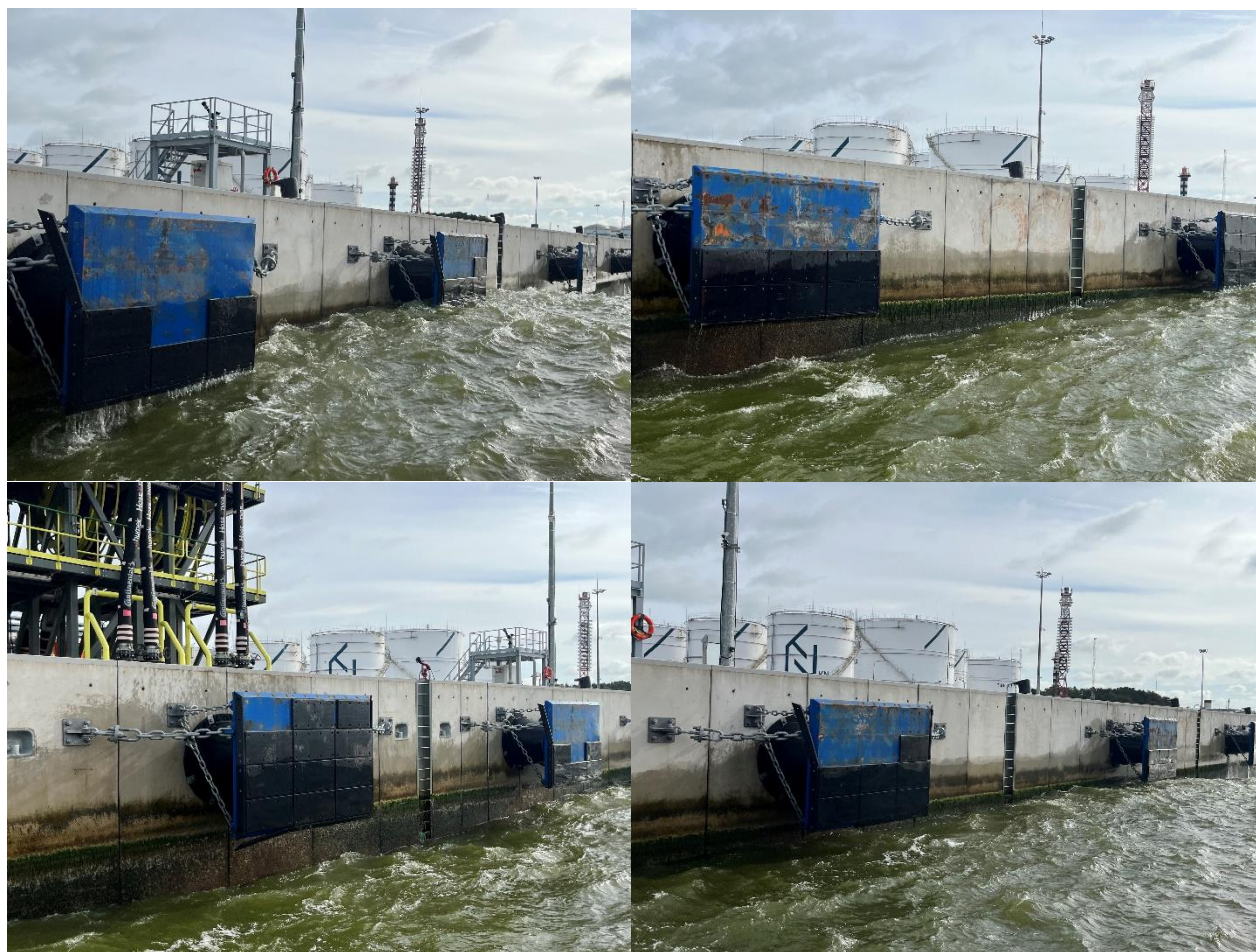
Pav. 1. Atmušos su pažeista plokščių slydimo paviršiaus danga krantinėje Nr. 1.
